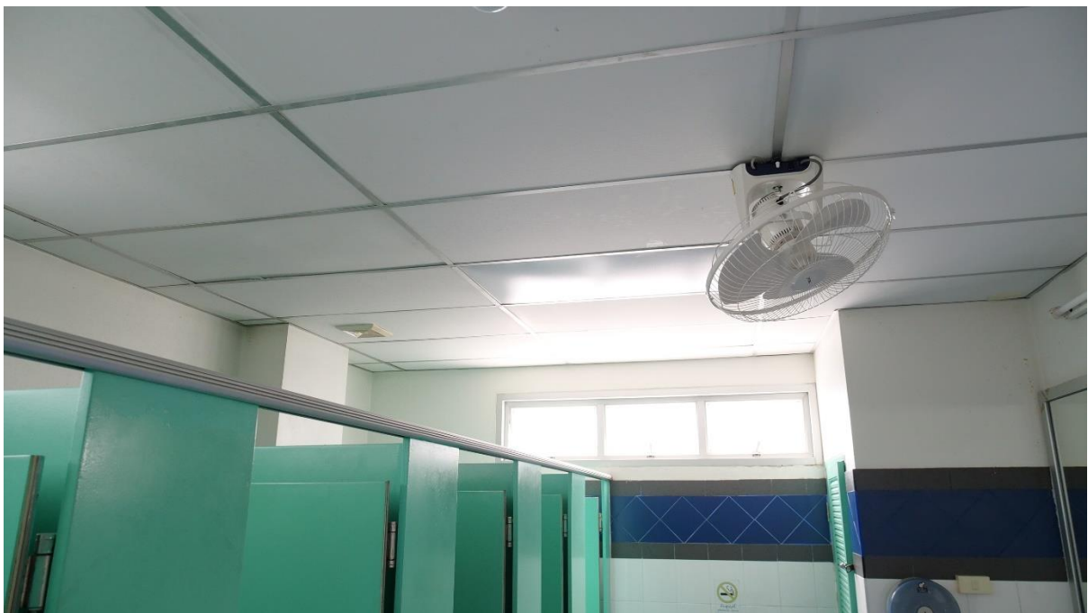
ติดพัดลมในห้องน้ำ
