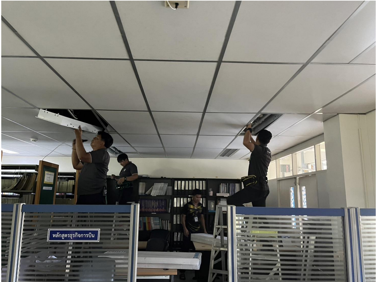
เปลี่ยนหลอดไฟห้องสมุด
